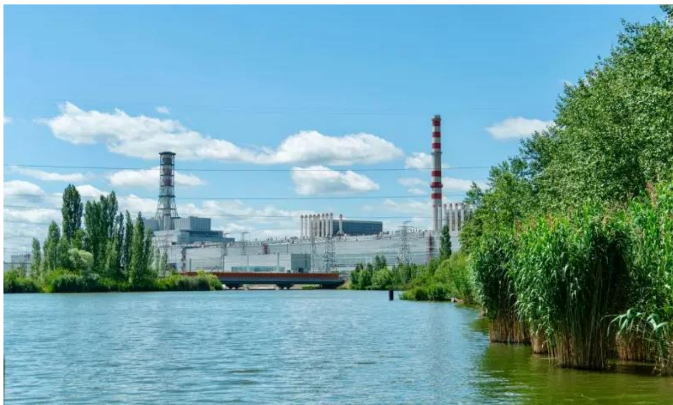
Autre vue de la centrale électronucléaire de Kourchatov (Oblast de Koursk) et ses quatre groupes RBMK de 1000 MW dont deux sont encore en service (Cf. carte ci-dessus, en haut à droite) Photo ROSATOM
