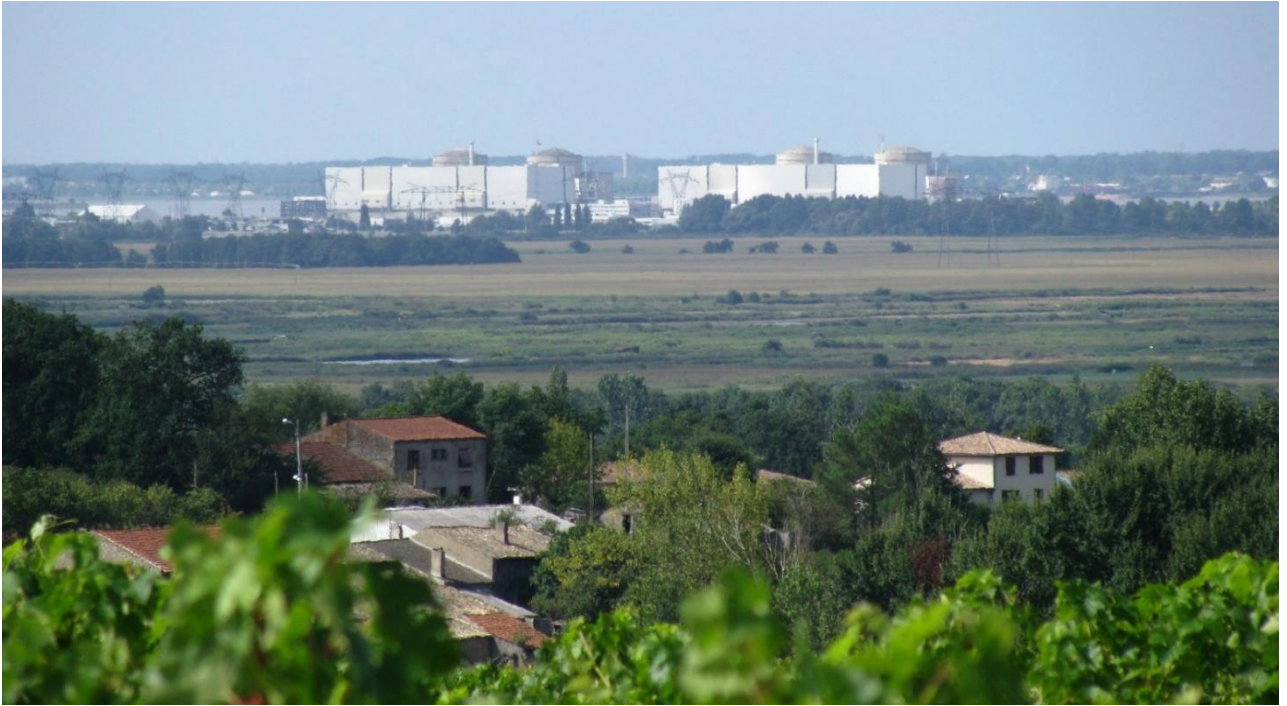
Centrale électronucléaire REP du Blayais (Département de la Gironde - France). Suite à la tempête du 27/28 décembre 1999, le marais, les champs ici visibles comme les premières habitations étaient par endroits de plusieurs mètres sous l'eau. Photo. A.D.
