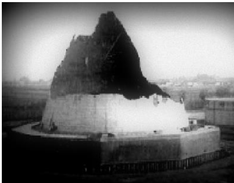
Effondrement puis construction provisoire de l'un des deux réfrigérants atmosphériques de la centrale à charbon de Bouchain (250 MW - Département du nord de la France) Photos. EDF
