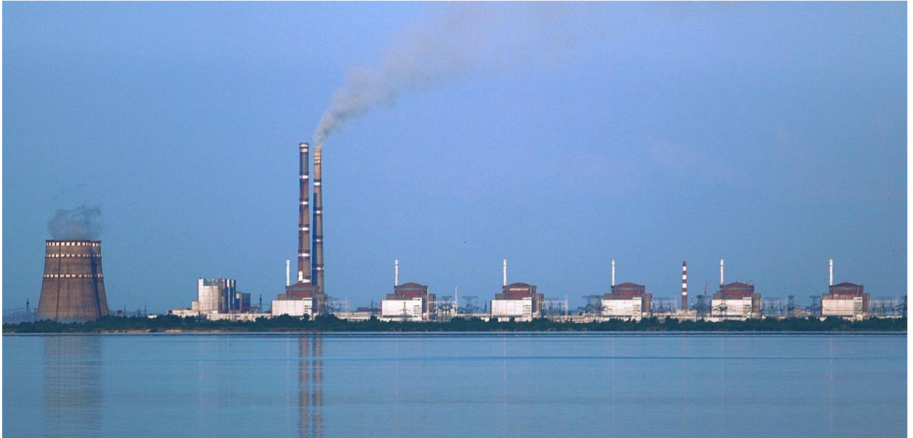
Centrale de Zaporijjia (Oblast de Zaporijjia - Ukraine mais sous gestion et protection russe). 6 groupes VVER de 1000 MW au bord de la retenue de Kakhovka alimentée par le Dniepr. Photo. ROSATOM
