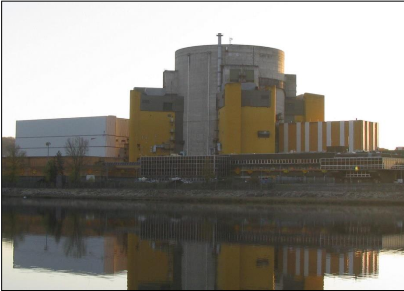
Surgénérateur de Creys Malville (Département de l'Isère). Unité neuve désormais en cours de démantèlement. Photo. J-MT avril 2022.
