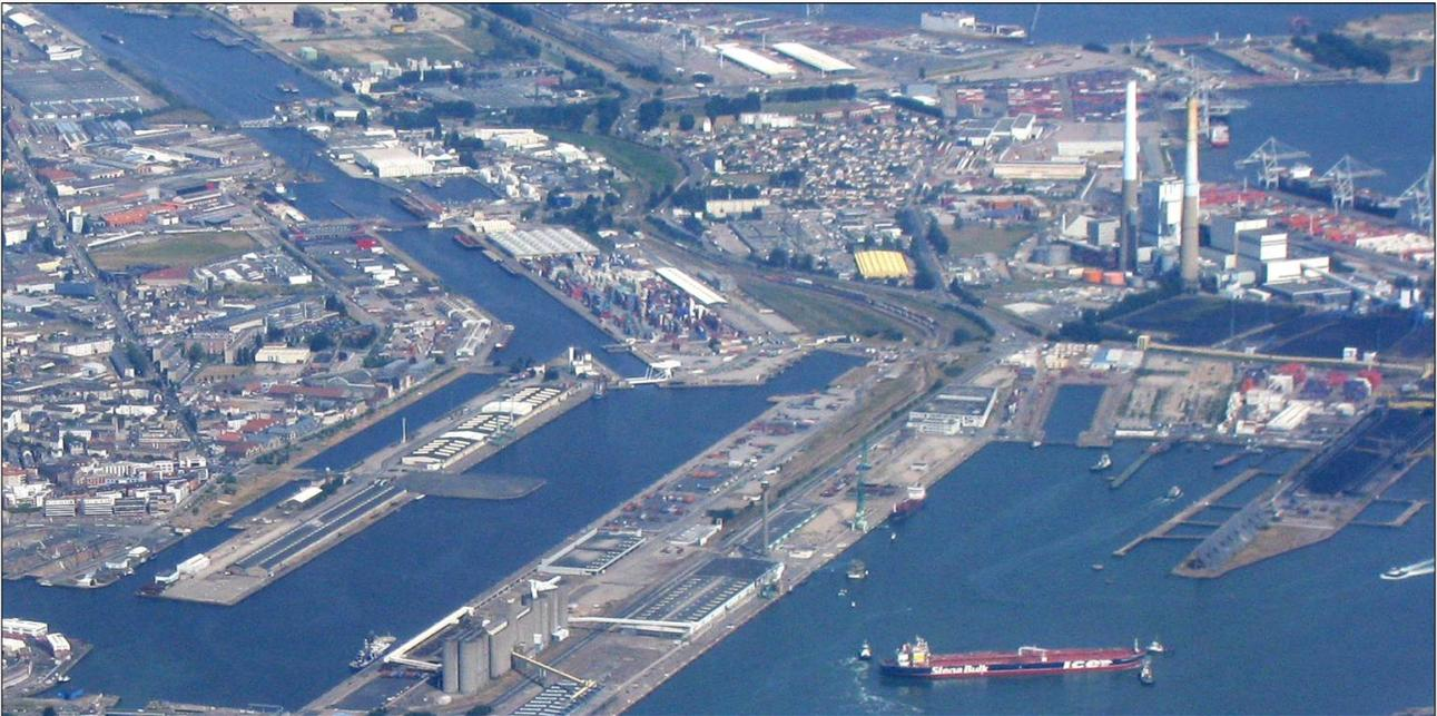
**Centrale à charbon de Le Havre en baie de Seine et une partie de son port pétrolier avec à droite de la photographie, la centrale thermique EDF. La tranche de 600 MW à charbon se situe au niveau de la cheminée de 240 m de hauteur (peinture blanche plus nette) et du bâtiment plus haut abritant la chaudière. Devant, ce sont les deux tranches de 250 MW, hors service.**
