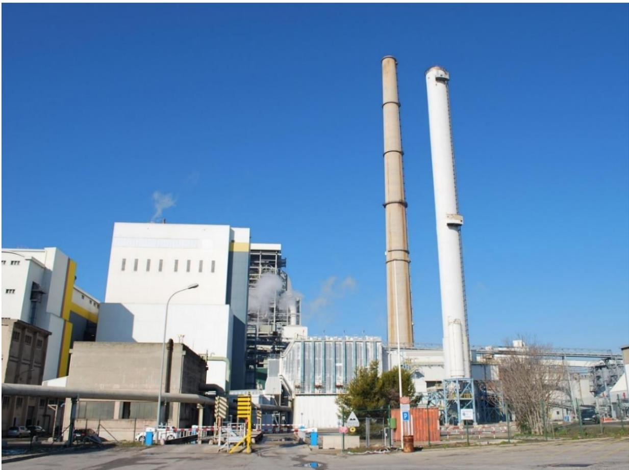
**Centrale 600 MW de Gardanne et ses deux réfrigérants atmosphériques. Sa chaudière à charbon se trouve derrière la cheminée blanche. La petite cheminée correspond à l'unité à biomasse de 150 MW dont de bardage de la chaudière est également blanc. Photo. JMT - Janvier 2021.**
