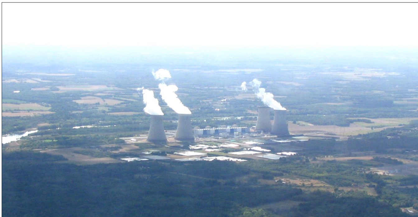
Centrale nucléaire REP de Dampierre en Burly (département du Loiret). Quatre tranches REP de 905 MW. Hauteur des réfrigérants atmosphériques : 165 m - Photo J-MT 2019.
